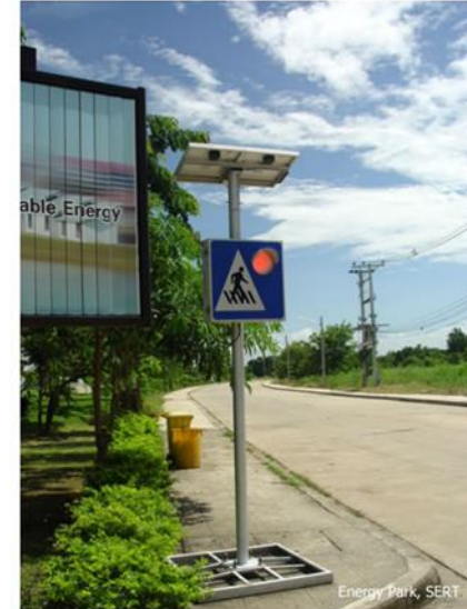
ระบบไฟสัญญาณพลังงานแสงอาทิตย์
